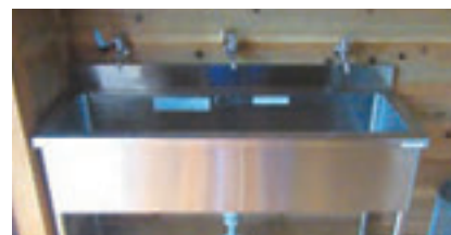
水道管、手洗い場、シャワー室の工事が完了
