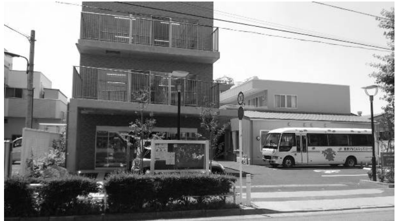
板橋センターに新しい建物。1階には障がいをもつ人の就労支援事業である、「カフェ JOY」がオープン!!
